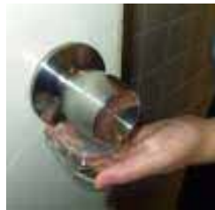
②出入口ドアノブ部分 (本社1階男子トイレ)
